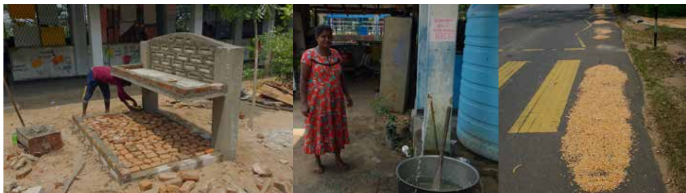
Das Waschbecken ist im Entstehen - Zur Zeit läuft noch das Provisorium - Traditionelle Maistrocknung
